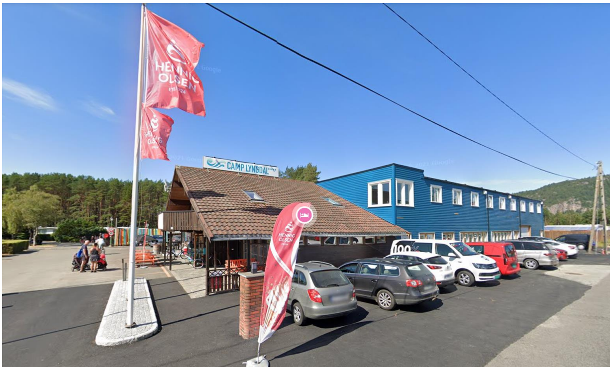
Figur 22: Hovedbygg med resepsjon og leiligheter. Foto: Google Maps
